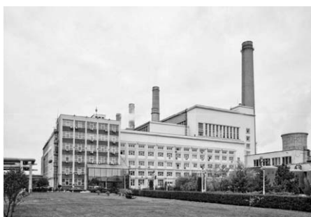
Fig. no.1 Overall view CET GOVORA
